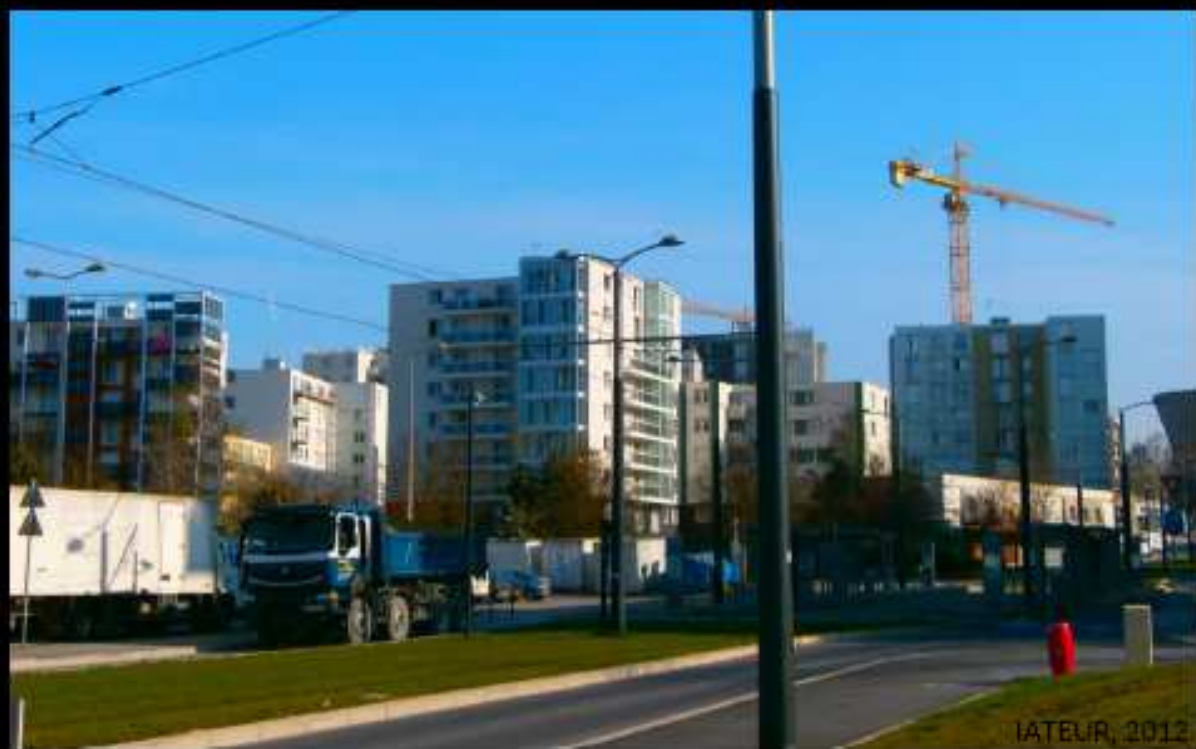
Les opérations de construction et de réhabilitation des façades du quartier Croix-Rouge
