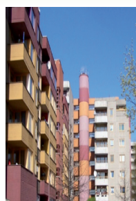
Immeubles avant les travaux
