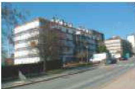
Réhabilitation immeuble Blaise
