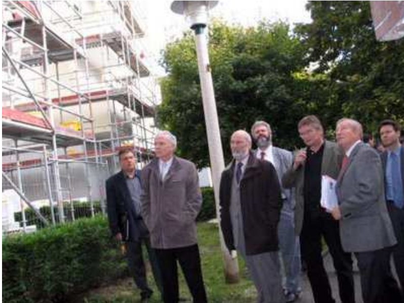
Au cours de la visite du chantier de Val-de-Murigny.
