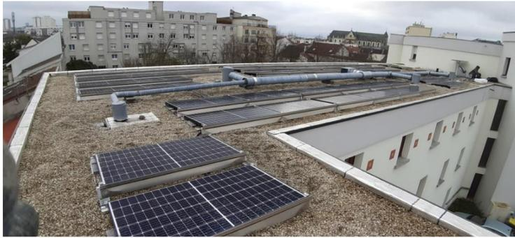
Production électrique photovoltaïque de 19 kWc de puissance (105 m<sup>2</sup> de surface), en injection du surplus.
