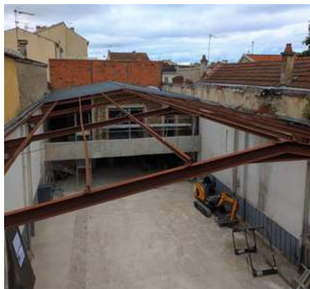
Conservation de la charpente métallique de l'ancien garage
