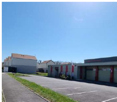
Caserne des pompiers avec en arrière plan les 8 maisons
