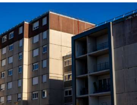
Bâtiment avant rénovation
