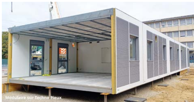
Figure 11 - La construction modulaire permet non seulement de gagner un temps de chantier considérable, de limiter les nuisances sur l'environnement immédiat, mais également de recourir à des systèmes de fondations plus légères et avec un impact 100 % réversible sur le site, ici par exemple avec des pieux vissés (Technopieux). © Techno Pieux France - Quatro Architecture
