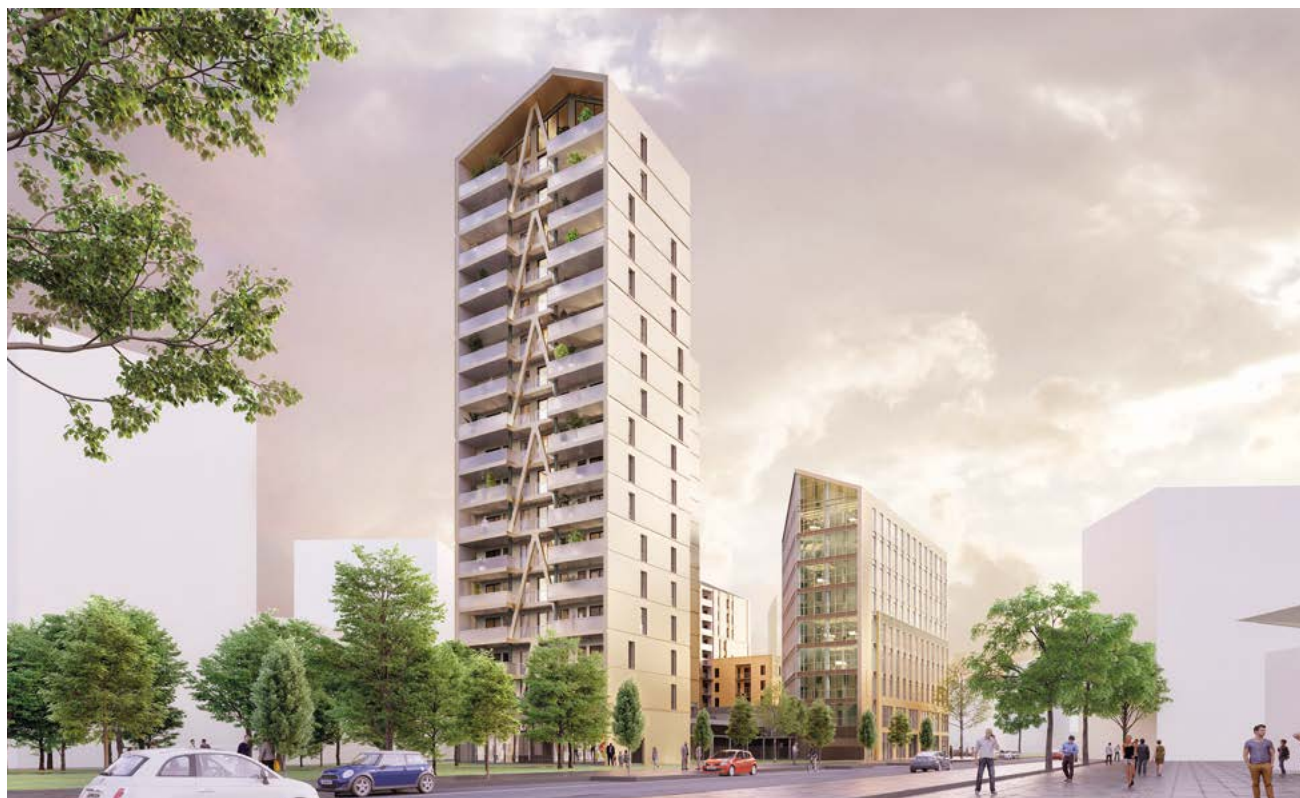
Figure 14 - La tour Silva (Artbuild Architectes) est le plus grand immeuble d'habitation en bois de France, il est constitué de prémurs, d'escaliers préfabriqués, d'une structure porteuse bois et CLT et de murs à ossature bois entièrement finis en atelier. © Artbuild Architectes
