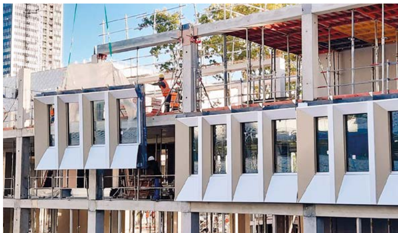
Figure 22 - Pose des façades à ossature bois (FOB) Techniwood en interface avec le gros œuvre béton sur la Cité Administrative de Lyon. © Z architecture.
