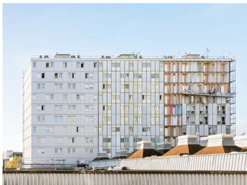
Figure 34 : Rénovation thermique par l'extérieur en panneaux 2D préfabriqués (Les Biscottes, architecte : Équateur). © Coline Bublex
