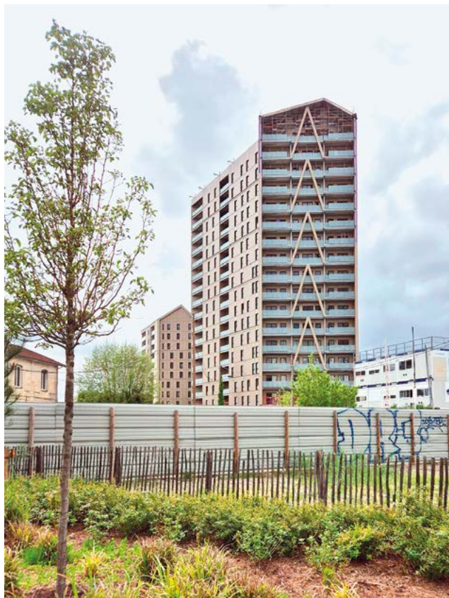
Figure 37 - Le chantier de la Tour Silva à Bordeaux en fin de réalisation. Une coordination poussée a été nécessaire pour orchestrer gros œuvre, structure bois, murs à ossature bois pour ce projet exemplaire (Artbuild Architectes). © Lynda Benkaci
