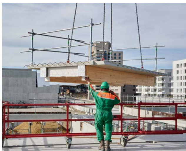
Figure 38 - Levage d'éléments de planchers mixtes «atom wood» de chez GA smart building pour leur siège social à Toulouse. © Philippe Rol - Studio Montazami et Tezuka Architects
