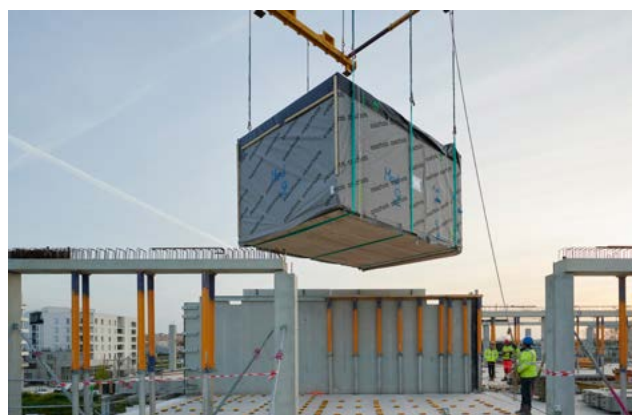
Figure 35 - Le levage et la pose de modules sanitaires nécessitent une prise en compte de l'accessibilité du site de mise en œuvre (modules sanitaires du groupe GA smart Building mis en œuvre sur la construction de leur siège social). ©Philippe Rol - Studio Montazami et Tezuka Architects
