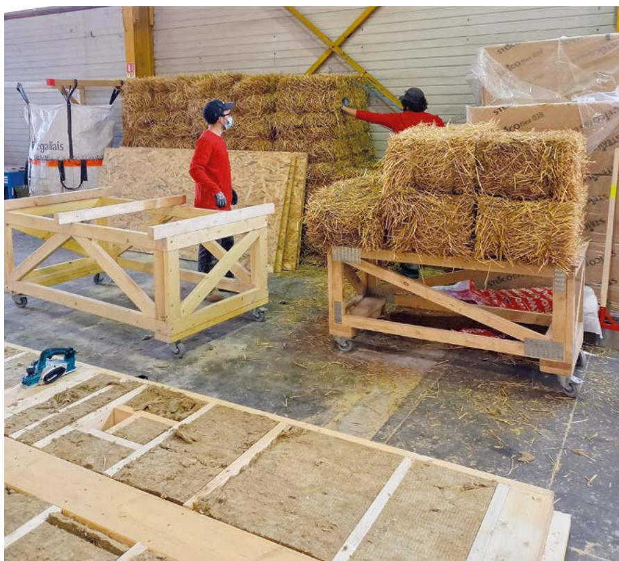
Figure 15 - Réalisation en atelier de murs à ossature bois avec remplissage en paille (Lycée Gergovie, Savare). © Eiffage - CRR Architecture
