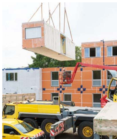
Figure 36 - Levage d'un module 3D pour une résidence sociale modulaire 3D déplaçable à Nantes réalisée par Avelis (Moon Architectures). © Cedric Colin
