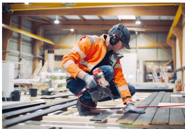
Figure 4 - Réduction de la pénibilité par l'accessibilité des éléments : ici un mur à ossature bois bardé à l'horizontale (Savare) © Eiffage - Tambours Battants
